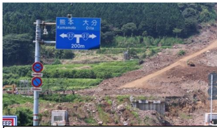
土でうまった道路を復旧する
