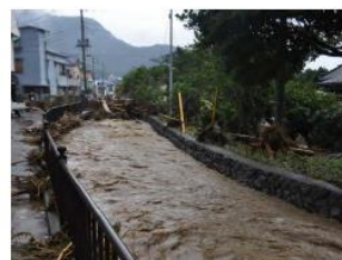
河川被害状況 安良里地区浜川
