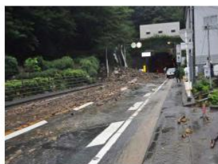
国道136号での土砂流出 宇久須地区
